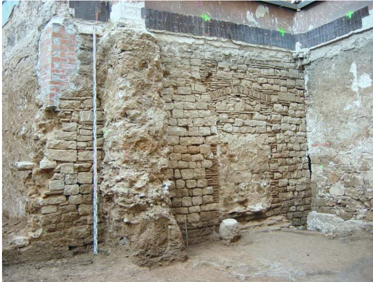
Foto superior: vista general del tram de paret oest documentat, amb una aparell uniforme, U.E.49.
